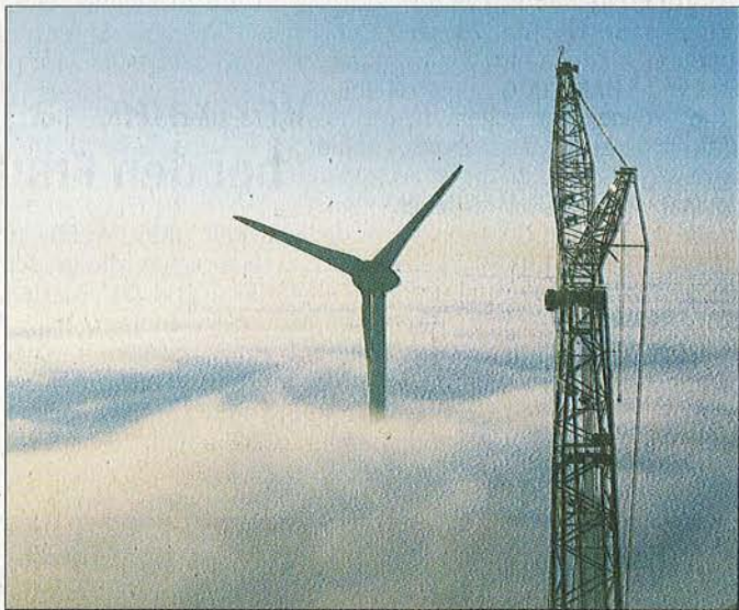
Windanlage Enercon E-126: Streit um die erforderliche Fundamenttiefe.
