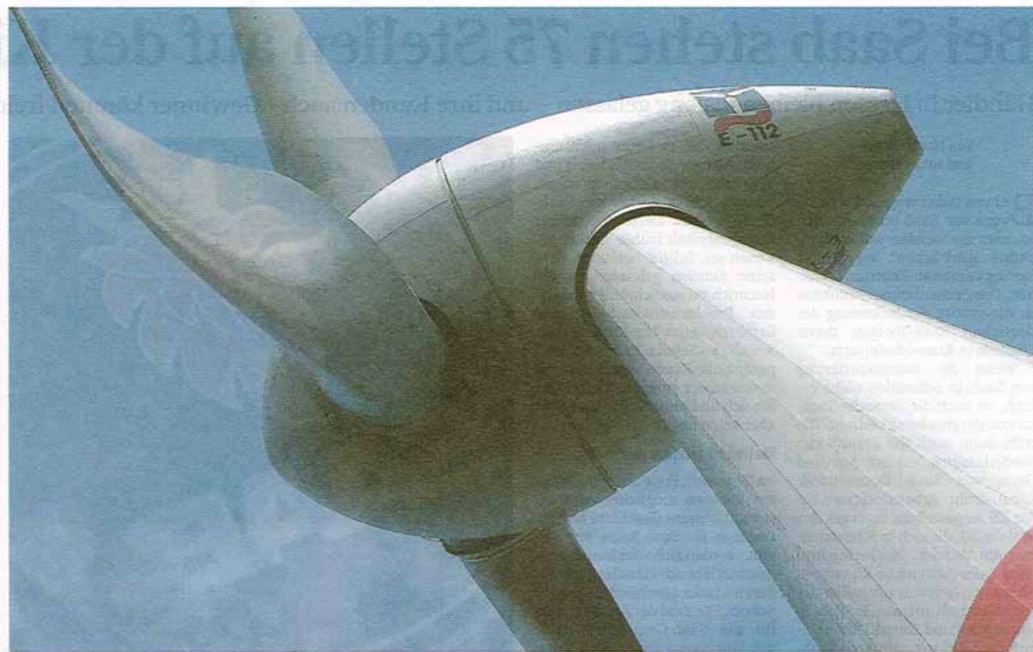
Mehr als 112 Meter Durchmesser haben die Rotoren der weltgrößten Windkraftanlage bei Emden.
